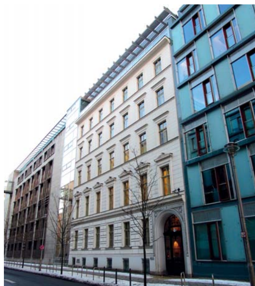
Die Geschäftsstelle der Chemischen Gesellschaft der DDR befand sich im Erdgeschoss der jetzigen Dorotheenstr. 99 in Berlin (weißes Gebäude in der Mitte). Fotos: Brigitte Osterath
