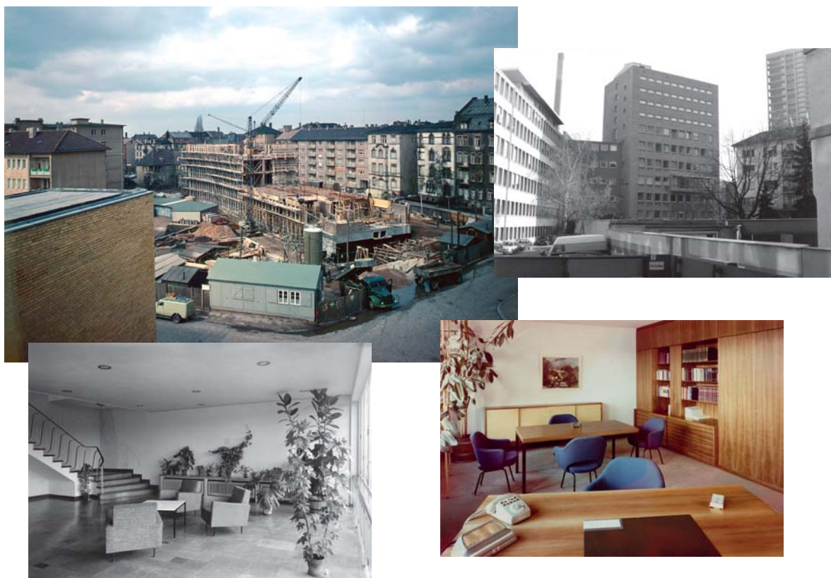
Oben links: Das Carl-Bosch-Haus entsteht; Baubeginn war im Jahr 1955. Es beheimatete zunächst nur das Gmelin- und das Beilstein-Institut. Im Jahr 1962 zog die GDCh-Geschäftsstelle in den neunstöckigen Erweiterungsbau des Carl-Bosch-Hauses (oben rechts), wo sie bis heute beheimatet ist. Unten links: Das Treppenhaus aus dem Jahr 1957 steht unter Denkmalschutz; unten rechts: das Chefzimmer im Jahr 1962. Es ist heute noch das Büro des GDCh-Geschäftsführers.
